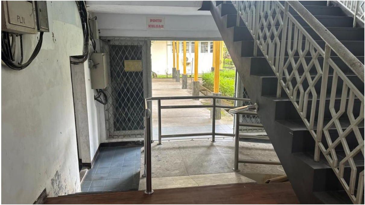
Lampiran 9 Jalan Pintu Keluar dan Menuju Toilet
